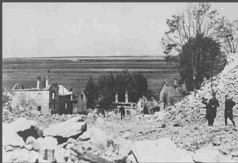
Разрушенные дома в Лидице
