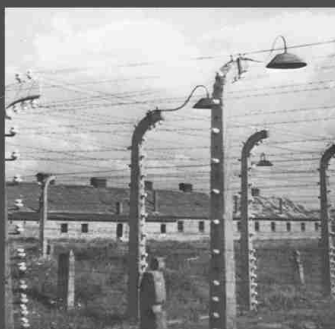
Вид на блок № 11, в подвале которого испытывался газ
